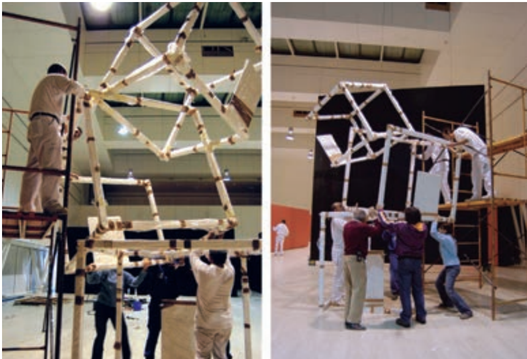
Fig. 7.- Placeres Bárbaros 2006. Composición del proceso de montaje estructura de acero.
